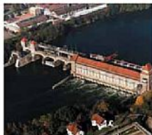
32/2 Průtočná vodní elektrárna v Laufenburgu na Rýnu
