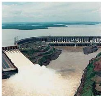
33/1 Vodní elektrárna Itaipú na hranicích Brazílie a Paraguaye
