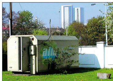
Monitorovací stanice AIM
